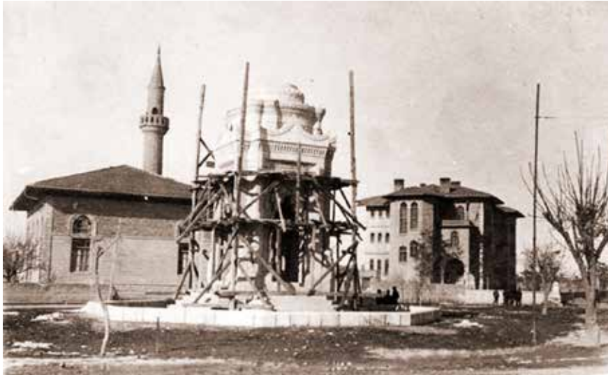
Ziraat Abidesi'nin inşaatı
