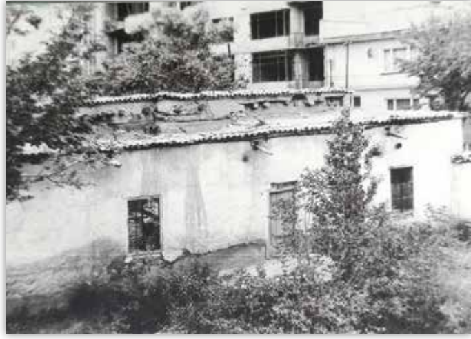
Restorasyon öncesi Ebu İshak Kazaruni Zaviyesi.
